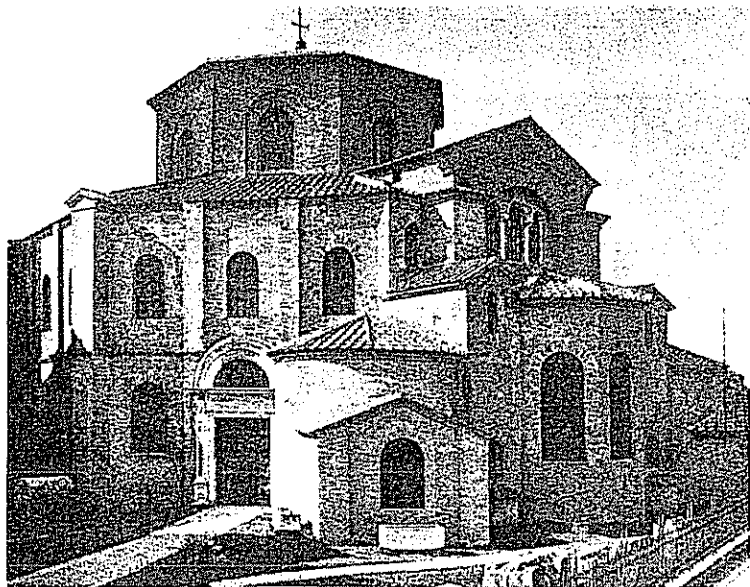
Izquierda: Fig. 76. San Vital (exterior del ábside), Ravena. Aproximadamente 526 a 547. Diámetro, 27 m.
